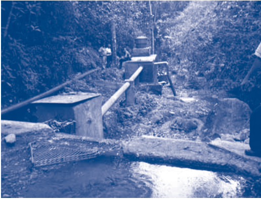
Figura 3.22 Una profusión de tuberías dificulta el monitoreo de las captaciones de agua en el riachuelo El Chocho (Foto: Grupo GIRH - Cinara)
