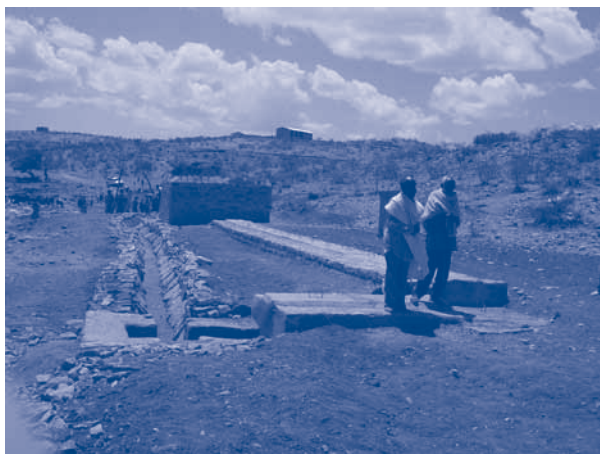
Figura 3.16 Galería de infiltración de agua potable (derecha), en el sistema multipropósito de Adidaero, Etiopía: el canal subterráneo de la presa de derivación se divide en un canal de riego (izquierda) y en una galería de filtración (Foto: Eline Boelee)
