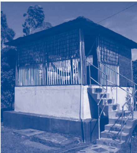
Figura 3.15 Un tanque de almacenamiento de agua exageradamente grande, como base para un bar-discoteca, en La Palma-Tres Puertas (Fuente: proyecto CPWF-MUS)
